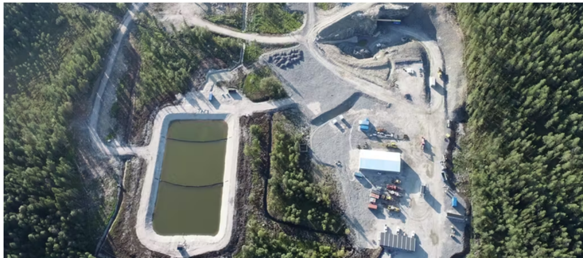
Figur 5: Botnia Explorations gruva i Fäbodtjärn [3] Källa: Botnia Exploration årsredovisning 2024
